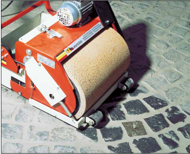
7 Abwaschen des Belags mit Reinigungsmaschine ...
