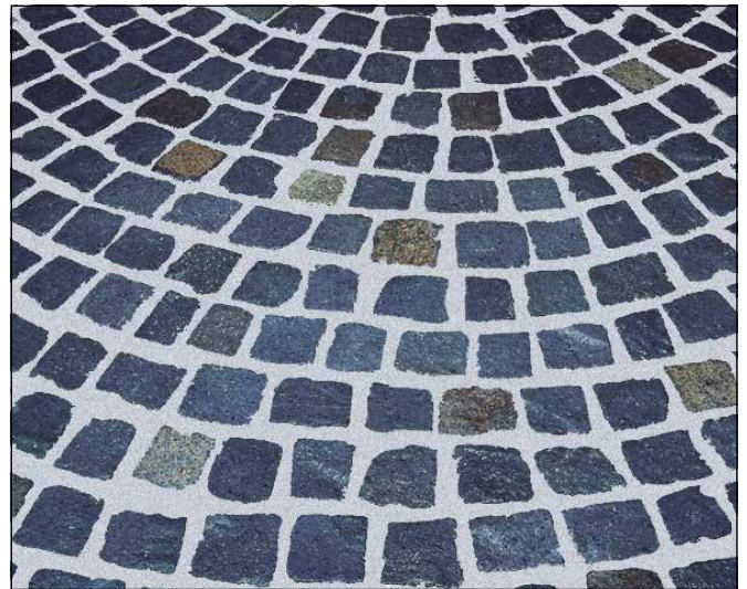
10 Fertig verfugter Belag.
