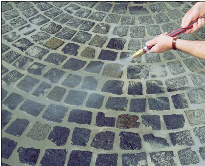
9 Absprühen mit feinem Wasserschlauchstrahl nach Erstarrungsbeginn des Fugenmörtels.
