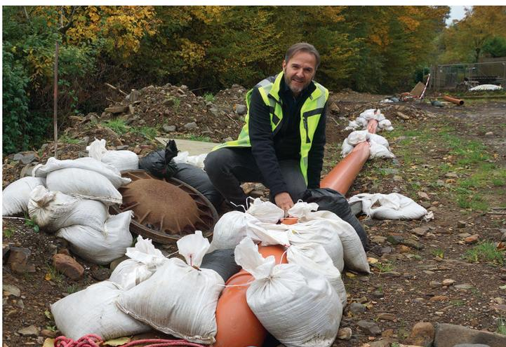
Der Leiter des Abwasserwerks, **Jürgen Adriany**, mit dem provisorischen Abwasserrohr, das über den Schutt hinweg oberirdisch verlegt und mit Sandsäcken stabilisiert wurde.
