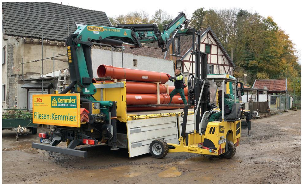
Im immer noch schlammigen und halb verlassenem Ortszentrum wurden die dringend benötigten Kanalrohre abgeladen und mit geländegängigen Staplern an die unzugängliche Baustelle geliefert. In nur zwei Stunden waren alle sechs Lastwagen entladen.
