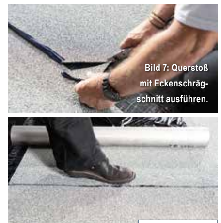
Bild 8 (Verlegung): Querstoß verschweißen und flächig andrücken.
