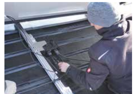
Bild 10: Die PV-Module werden an den Mikro-Wechselrichter angeschlossen.
