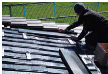
Bild 4: An den Seiten kommen Anschlussbleche zum Einsatz
