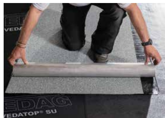
Bild 1: Turbo TO im Lagenversatz zur Unterlage ausrichten, straff auf den Wickelkern aufrollen und bis ca. zur Bahnenmitte zurückrollen.
