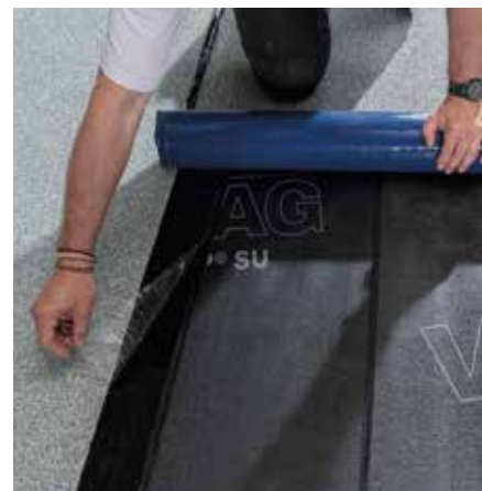
Bild 2: Ab zweiter Bahn: Längsrandstreifen in Richtung der Bestreung lösen und abziehen.
