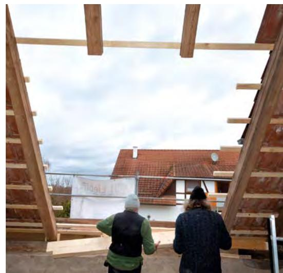
Oben und unten wurde ein stabiler Wechsel mit stabilen Balken vorbereitet, zugeschnitten und eingebaut
