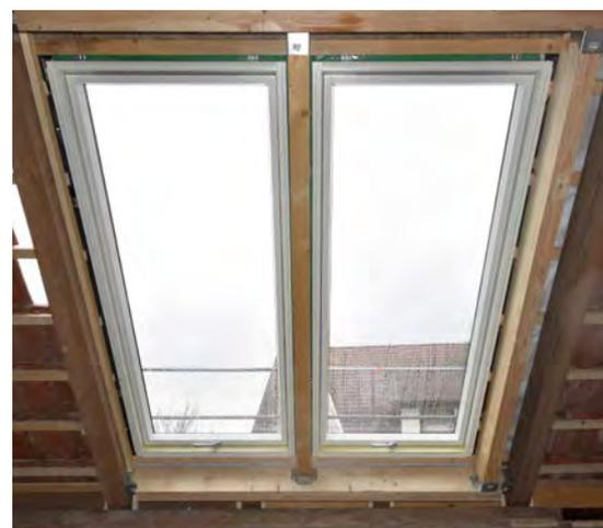
Eingebaut wurden zwei Dachfenster vom Typ FYU-V U3 proSky mit höher versetzter Schwingachse, U3 Zweifach-Isolierglas und der regulierbaren V40 P Lüftungsmechanik. Der Flügel besitzt eine Schwingfunktion mit höher versetzter Drehachse, schwenkbar um 160° zur arretierbaren Putzstellung.
