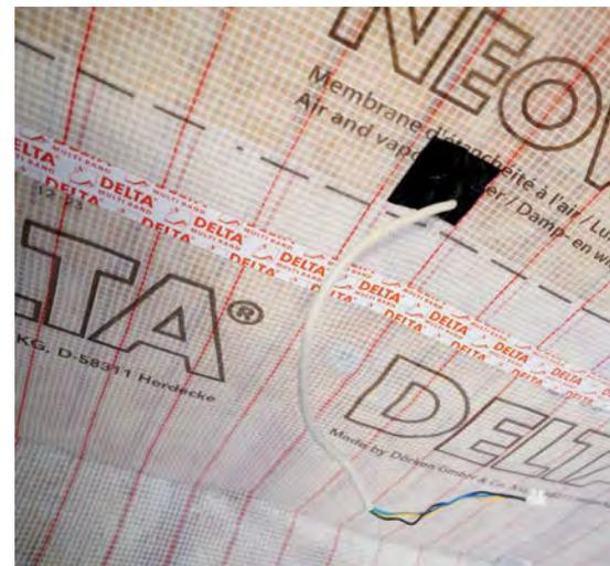
In Abhängigkeit von der verwendeten Dacheindeckung können bei Unterschreitung der Regeldachneigung Zusatzmaßnahmen der Klasse 1 oder Klasse 2 erforderlich sein. Hierfür können entweder nicht diffusionsoffene Abdichtungen (regensicheres bzw. wasserdichtes Unterdach) mit einer Belüftungsebene über der Wärmedämmung oder Unterdeckungen mit nahtgefühten Unterdeckbahnen ohne Belüftungsebene verwendet werden.
