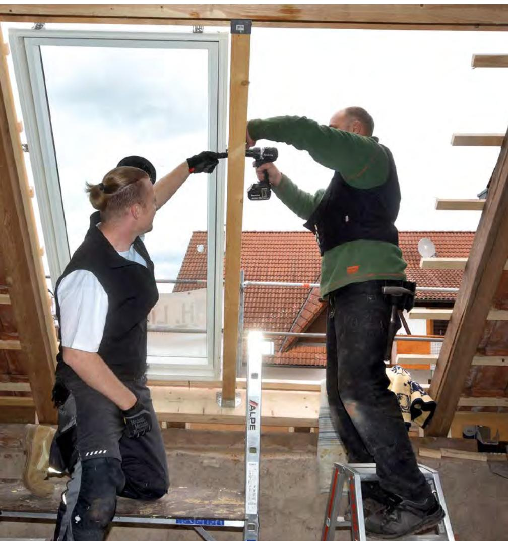
Der horizontale Abstand zwischen den zwei Fensterelementen und der Abstand zum oberen und unteren Balken mussten exakt parallel verlaufen, damit der Kombieindeckrahmen, der beide Fenster zusammen in die Dacheindeckung integriert, akkurat passt
