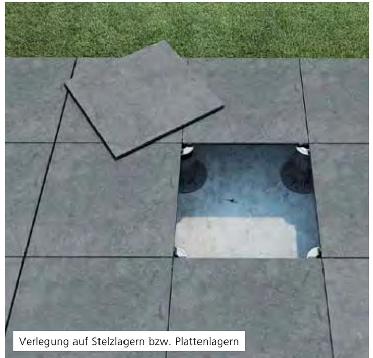
Verlegung auf Stelzlager bzw. Plattenlagern
