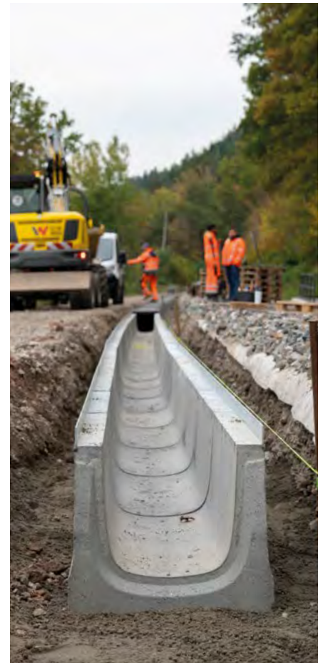
Für einen passgenauen und schnellen Einbau können die Einzelelemente im 90°-Winkel oder individuell auf Gehrung zugeschnitten werden
