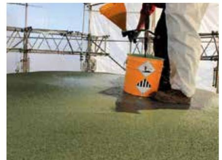
Die abschließende Schiefersplitt-Einstreuung wurde pneumatisch gleichmäßig aufgetragen.
