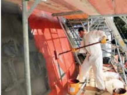
Das Sikalastic Flüssigkunststoffsystem geht einen direkten Verbund mit der Wärmedämmung ein und passt sich über die Systemvlieseinlage Reemat Premium frei an die Kuppelform an.
