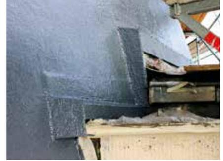
Details und Anschlüsse an die benachbarten Blechdächer und Gebäudeteile lassen sich funktionsicher und einfach mit dem Flüssigkunststoffsystem ausführen.
