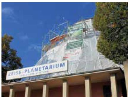
Die außergewöhnliche Geometrie der Kuppel machte eine freitragende, aufwändige Gerüstkonstruktion erforderlich.
