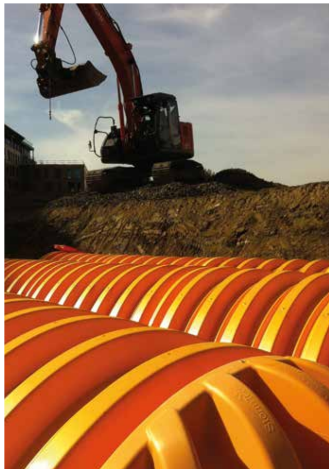
BIRCO Rigolentunnel von StormTech® mit großem Fassungsvermögen
