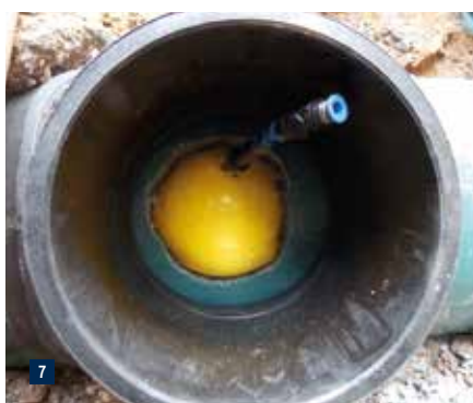
Ballon zur Abdichtung der Notöffnung nach der Schweißung.
