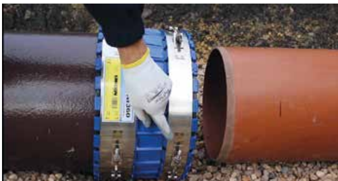
Ist das breite Spannband der UNICON-Manschette mit dem erforderlichen Drehmoment angezogen, wird das kleinere Rohr in die offene Seite geschoben.
