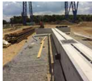
Monolithische Ablaufelemente mit starker Gußabdeckung & umlaufender Stahlkante.
