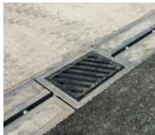
Monolithische Ablaufelemente mit starker Gußabdeckung & umlaufender Stahlkante.
