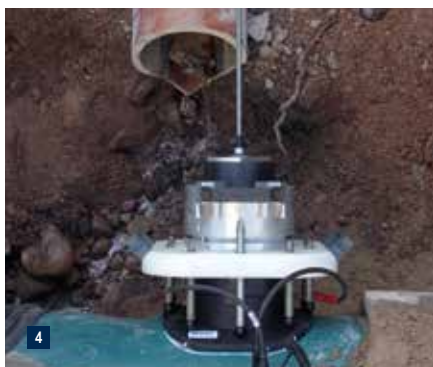
In der Wolfshohlstraße: Abwassersattel ASA-TL montiert mit kompaktem Aufspanngerät ASATOP.
