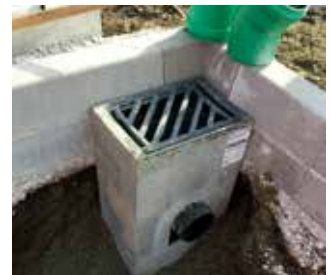
Monolithische Straßenabläufe m. verankerter Gußabdeckung, schnelles setzen, hohe Dichtigkeit.
