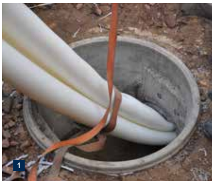
In der Wiesenstraße: PE-Liner wird über Revisionschacht eingezogen.
