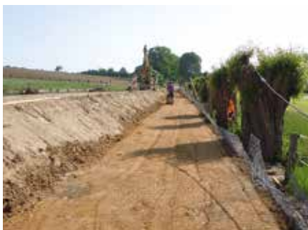
Einbau der GREEN TERRAMESH Elemente
