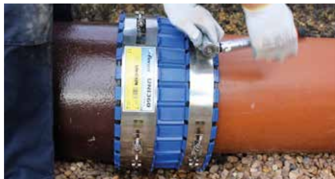
Die Rohrverbindung über die UNICON ist sicher hergestellt, sobald auch das schmale Spannband mit dem angegebenen Drehmoment angezogen ist.
