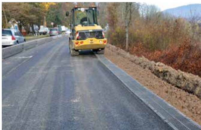
DRAINFIX CLEAN Filtersubstratrinne reinigt Oberflächenwasser entlang der Bundesstraße B 462.
