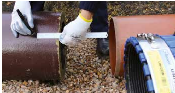
Flexseal Einbau: Passendes UNICON auswählen und mit dem breiten Spannband bis zur Anschlaglippe auf das größere Rohr schieben.
