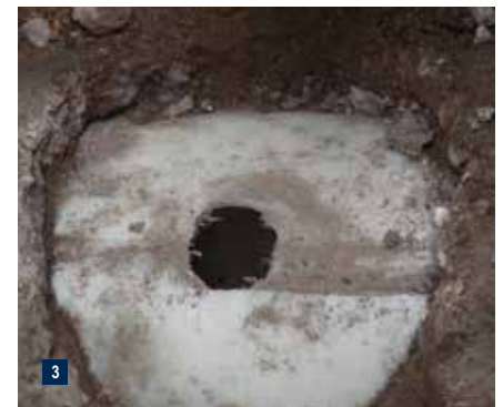
Freigelegter PE-Liner mit Notabfluss in Fensteröffnung.
