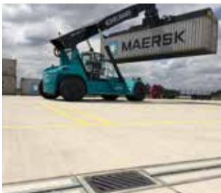
Tief verankerte Stahlkante als Oberflächen-schutz.
