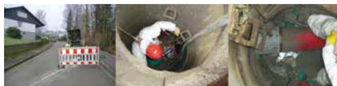
Beispiel Maßnahme Wiehl, Press-Bersten dimensionsgleich von Schacht zu Schacht
