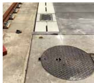
Brandschutzgeeinte Materialien & absperbarer Schieberschacht.
