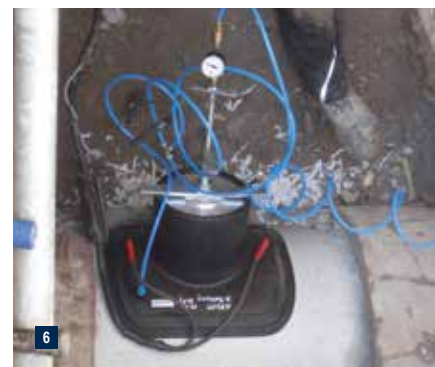
Mit VACUSET XL aufgespanntem Abwassersattel ASA-VL mit Abgang d 225.
