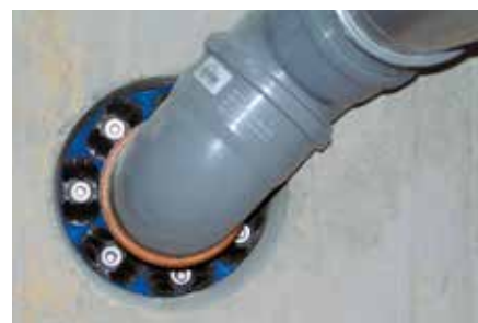
Produkt LINK-SEAL® in eingebautem Zustand.
