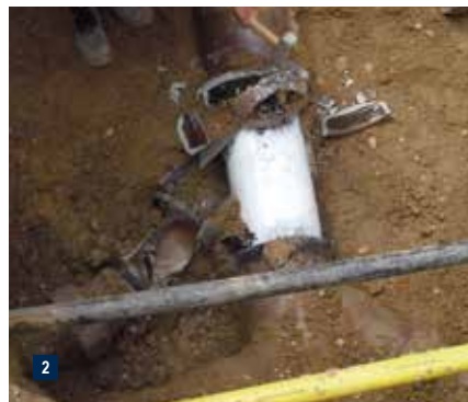
Altrohr wird am Anschlusspunkt zerstört.
