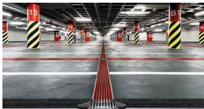
Die PG EVO lässt sich direkt auf dem Rohbeton verbauen, so dass zusätzliche Vertiefungen entfallen und die Stahlbewehrung der Betondecke geschützt bleibt. Das umfangreiche Zubehörprogramm enthält unter anderem Abfluss- und Kreuzungselemente aus Edelstahl. (Fotos: MEAAG)
