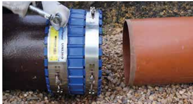
Beide Spann-Bänder der UNICON-Manschette abwechselnd und gleichmäßig anziehen, bis die Manschette auf dem großen Rohr fest anliegt.
