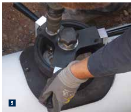
Anbohrgerät FWFIT im Einsatz.
