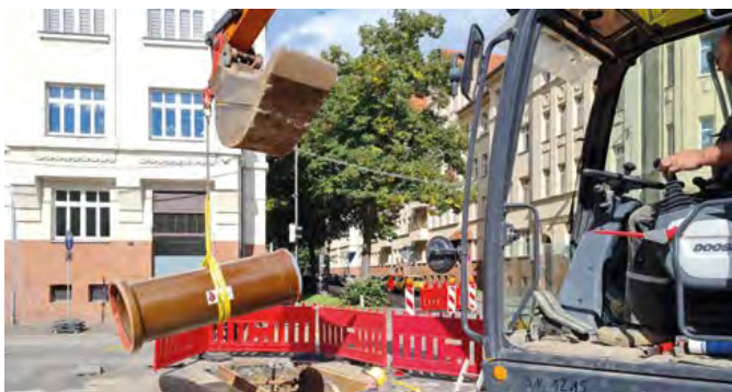
1. Antransport eines weiteren Rohres
