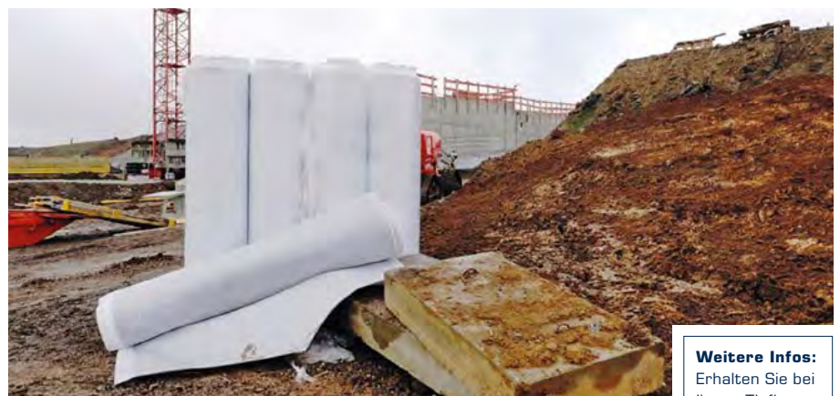
Angeliefert zum Einbau: Drainagematte FRANK FDV-2F
