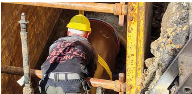
3. Das Rohr wird positioniert
