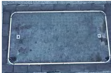
Schachtabdeckung aus Glasfaserverbundwerkstoff: Die nichtmetallische FibreIndustrial-Abdeckung von KHK behindert den Aufbau des Magnetfeldes für den Ladevorgang der Elektrotaxis nicht
