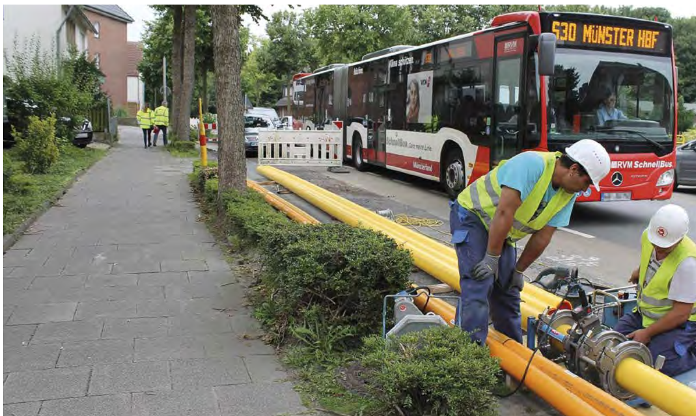
Verlegung von PE 100 RC und PA 12 Gasrohren
