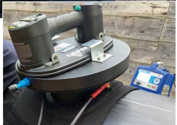
Während des Schweißvorgangs wird das Vakuum gehalten
