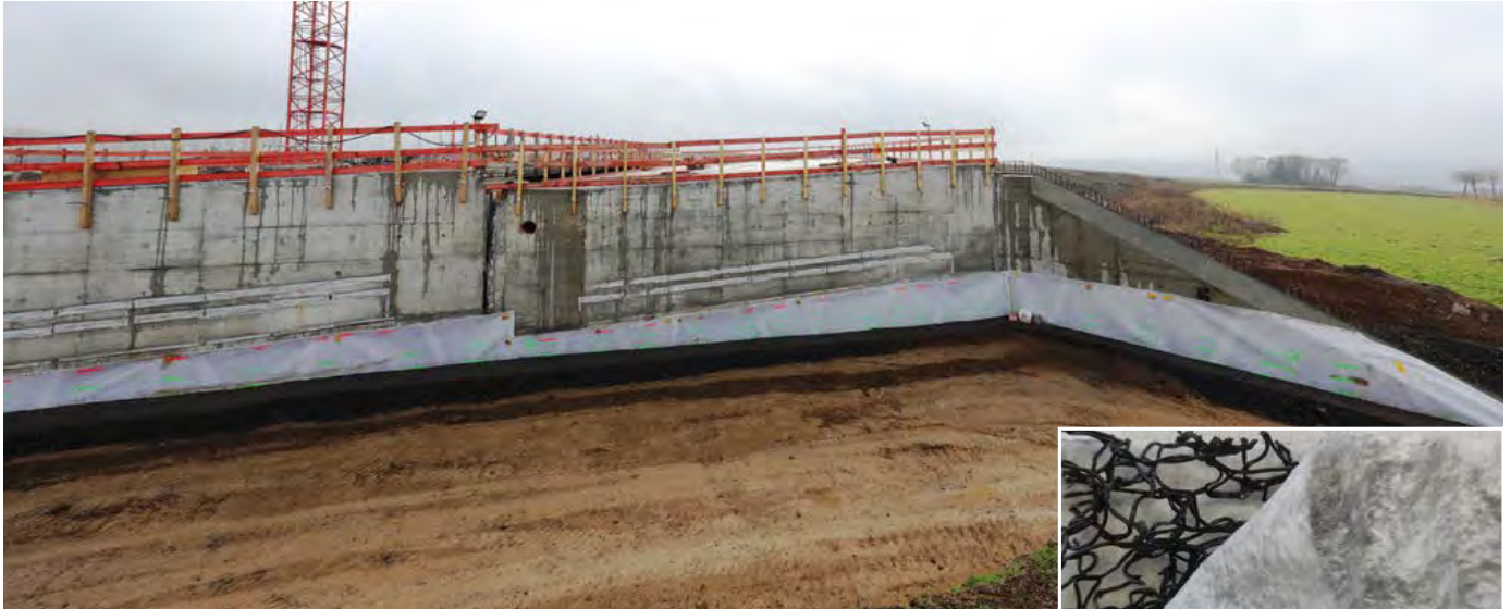
Baustellenansicht – Drainagematte FRANK FDV-2F eingebaut als Vertikaldrainage
