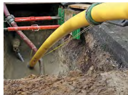
Einzug des Polyamid 12 Gasrohres im HDD-Verfahren
