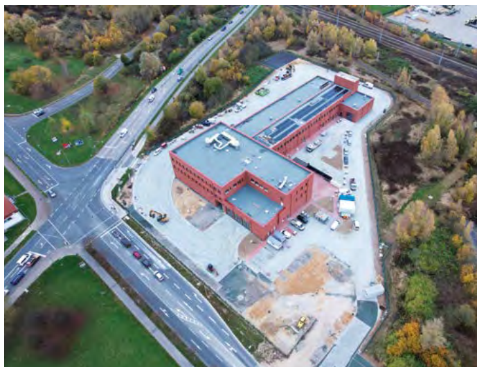
Die neue Feuer- und Rettungswache liegt verkehrsgünstig im Nordosten von Rostock (Foto: aib-Bauplanung Nord)
