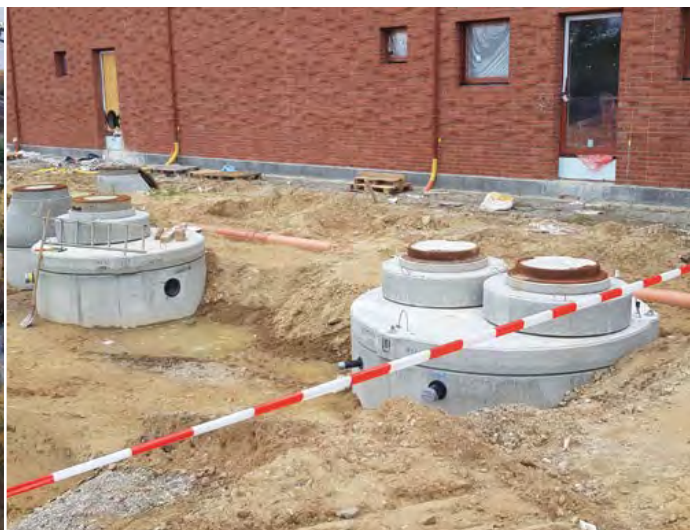
Sicherheitsauffangbecken und Leichtflüssigkeitsabscheider wurden außerhalb der Fahrzeughalle eingebaut (Foto: aib-Bauplanung Nord)
