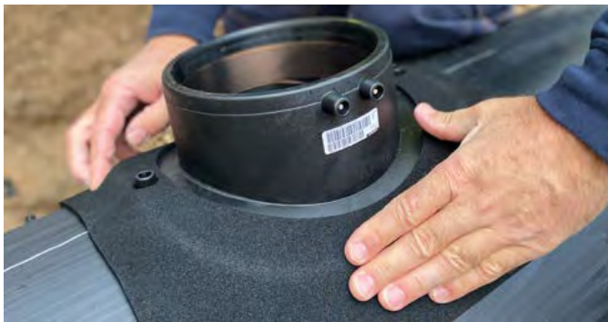
Mit der selbstklebenden Gummimatte wird bei ASA VL d160 der Sattel auf dem Rohr abdichtet
