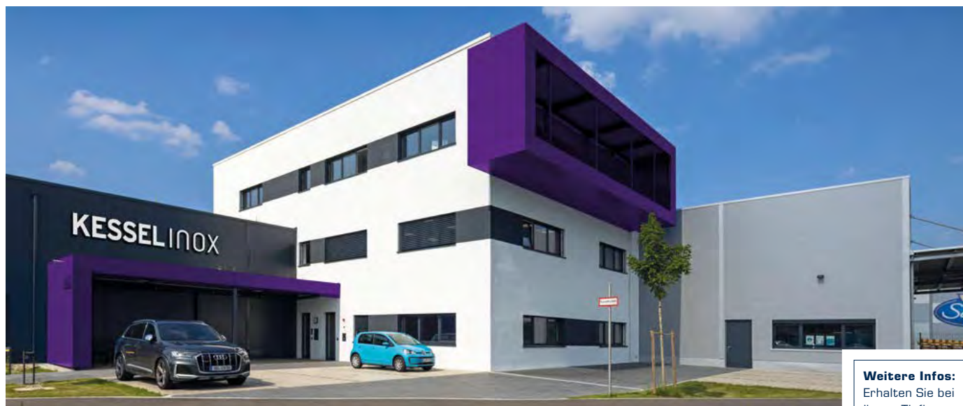
Neu-Ulm ist der Standort des neuen Edelstahl-Kompetenzzentrums KESSEL Inox
