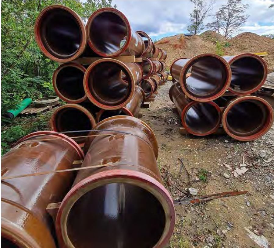
Das Rohrlager nahe der Baustelle im Zentrum von Leipzig
