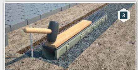
**3** Rinnenstrang, Einlaufkästen auf das Betonbett aufsetzen. Bauteile eben ausrichten.
