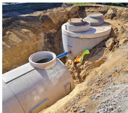
**Unter der Dorfstraße in Kleve am Niederrhein wird das Straßenabwasser zunächst behandelt und anschließend versickert**
