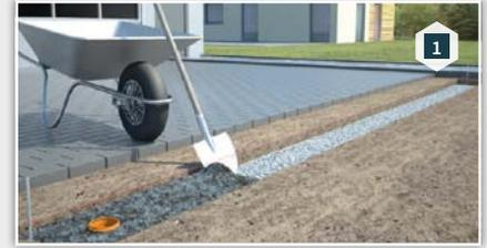
**1** Graben ausheben. Tragschicht einfüllen und vorverdichten. Betonbett, 3 Teile Sand + 1 Teil Zement + 1 Teil Wasser, auf Tragschicht aufbauen.
