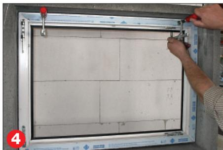
5. Fensteraußenrahmen mit den beigefügten Schrauben durch die Führungsbuchsen in den Dübelklötzen verankern. Bei 100 und 125 cm breiten Fenstern zusätzlich eine Schrauben senkrecht nach oben eindrehen.
