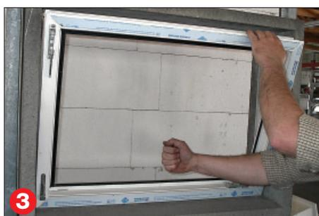
4. Fensteraußenrahmen gegen den Außenanschlag drücken und mit Schraubzwingen festklemmen. Beachten, dass die Dichtung am Fensterrahmen allseitig press am Anschlag anliegt.
