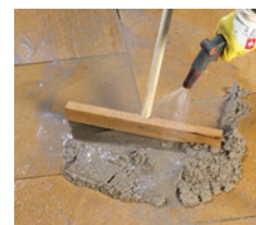
Mörtel mit Hartgummi-schieber und Wasser-sprühstrahl einarbeiten.
