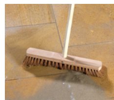
Letzte Mörtelreste ggf. mit Kokosbesen entfernen.
