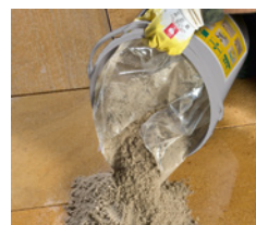
Mörtel portionsweise aufbringen.
