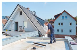
Rollen Sie danach die Drainagematte bündig aus und schließen die Vliesüberlappung längsseitig.
