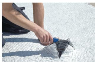
Setzen Sie den Kontrollschacht über den Dachablauf bzw. fassen Sie diesen mit Kies ein (optional).
